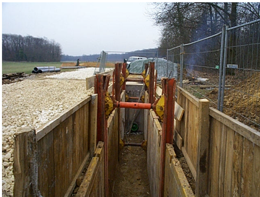
Figure IV-27. Vue de la tranchée expérimentale.
