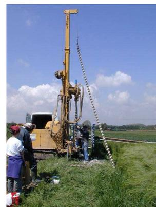
Tout au long des forages, des prélèvements d'échantillons solides ont pu être réalisés permettant ainsi la description de la géologie locale (Fig.8.27).
