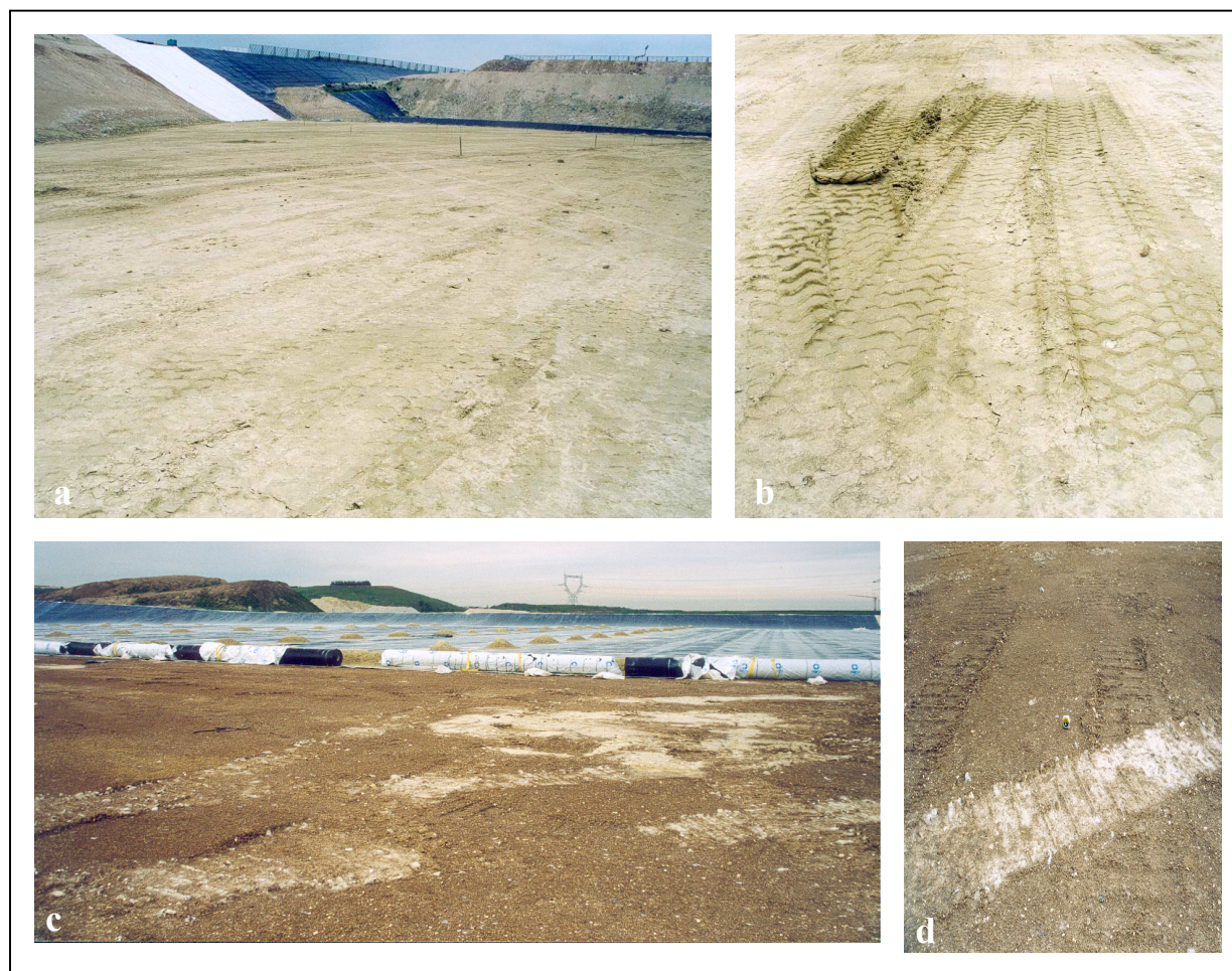
Figure III-1 : Photographies d'états de surfaces de barrières minérales juste avant la pose des géosynthétiques (clichés F.Cartaud)
