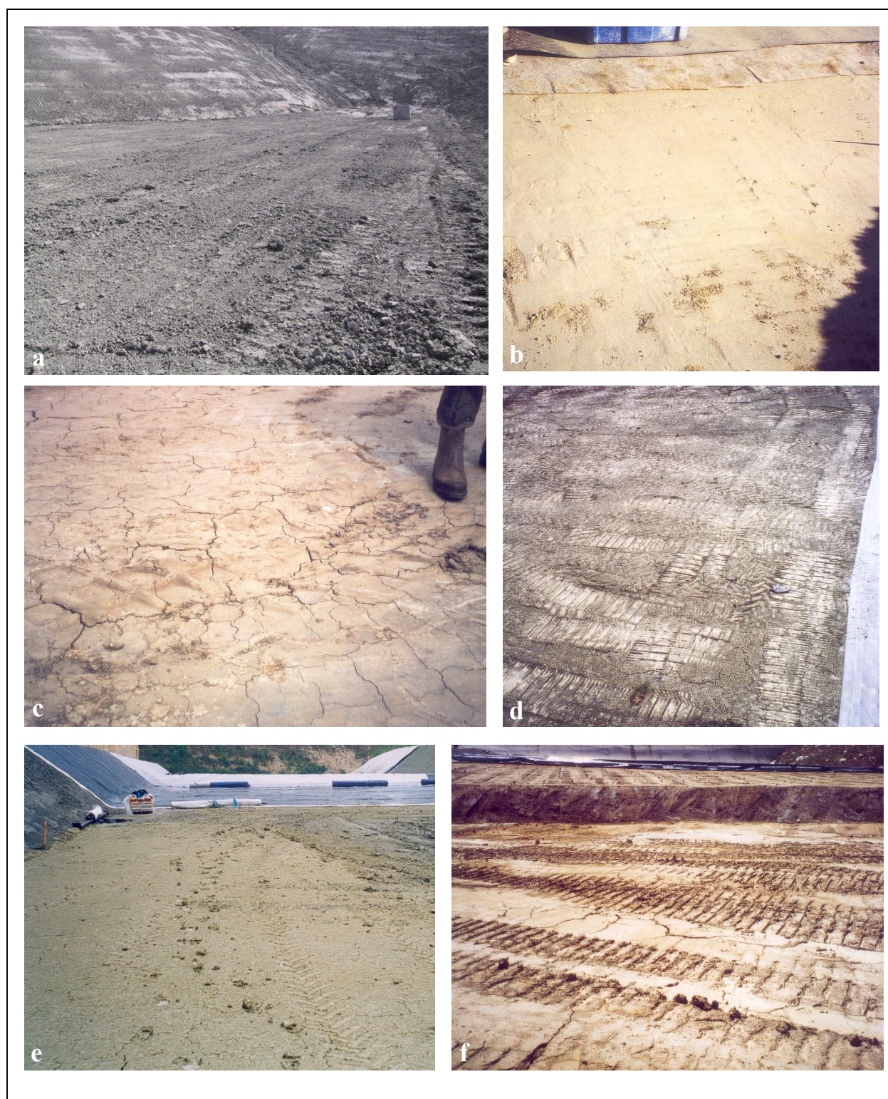
Figure III-2 : Photographies d'états de surfaces de barrières minérales juste avant la pose des géosynthétiques (clichés F.Cartaud)
