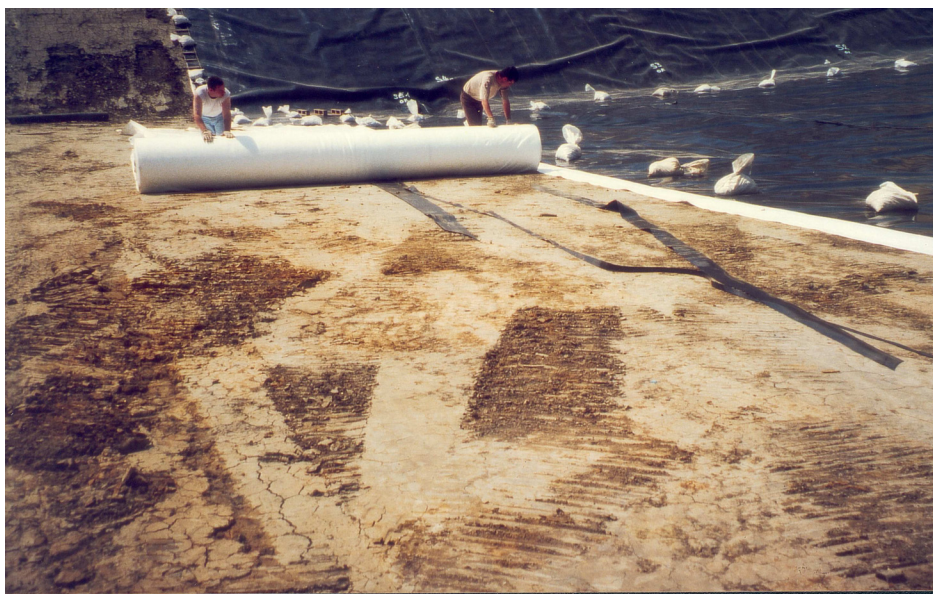
Figure I-8 : Pose d'un géotextile entre la barrière minérale et la géomembrane en fond d'ISD de classe II
