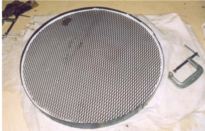
Figure AIV-3: la grille de renforcement d'acier est mise en place
