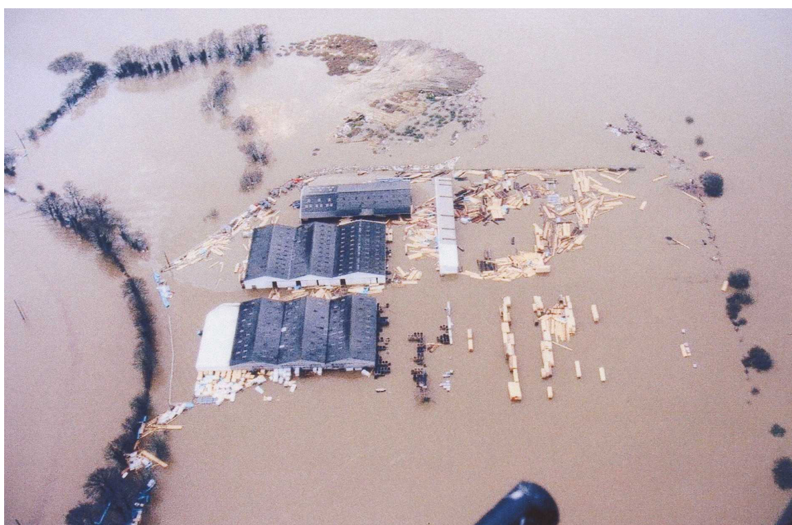
Photo 4 : Vue aérienne d'une entreprise sinistrée, 1995. Source : Comité du Marais Breton
