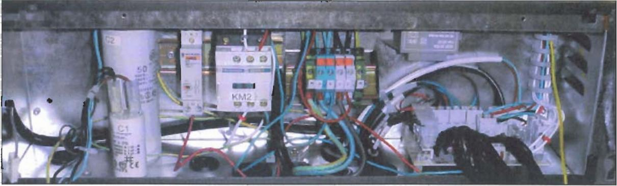
**Figure 3-6 : Tableau électrique de la PAC avant modifications**
