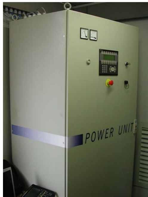
Electrolyseur alcalin de 3,6 kW (Hydrogen Systems) et son unité de contrôle (à droite).
