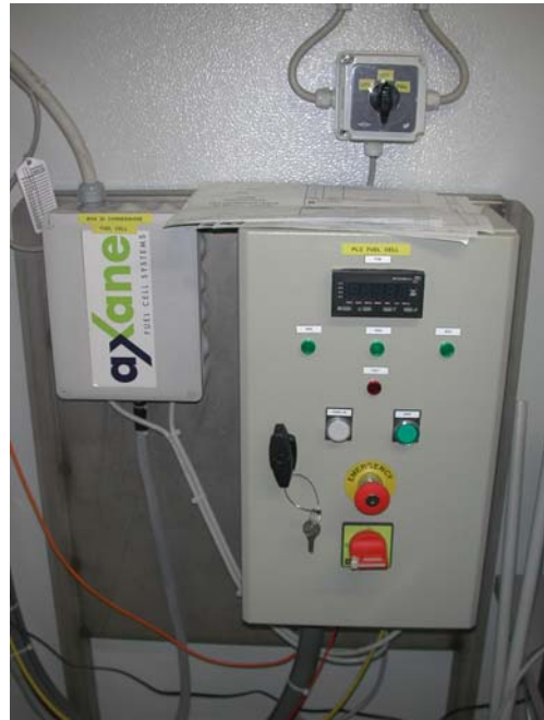
Pile à combustible PEM de 2 kW (Air Liquide) et son unité de contrôle (à droite).
