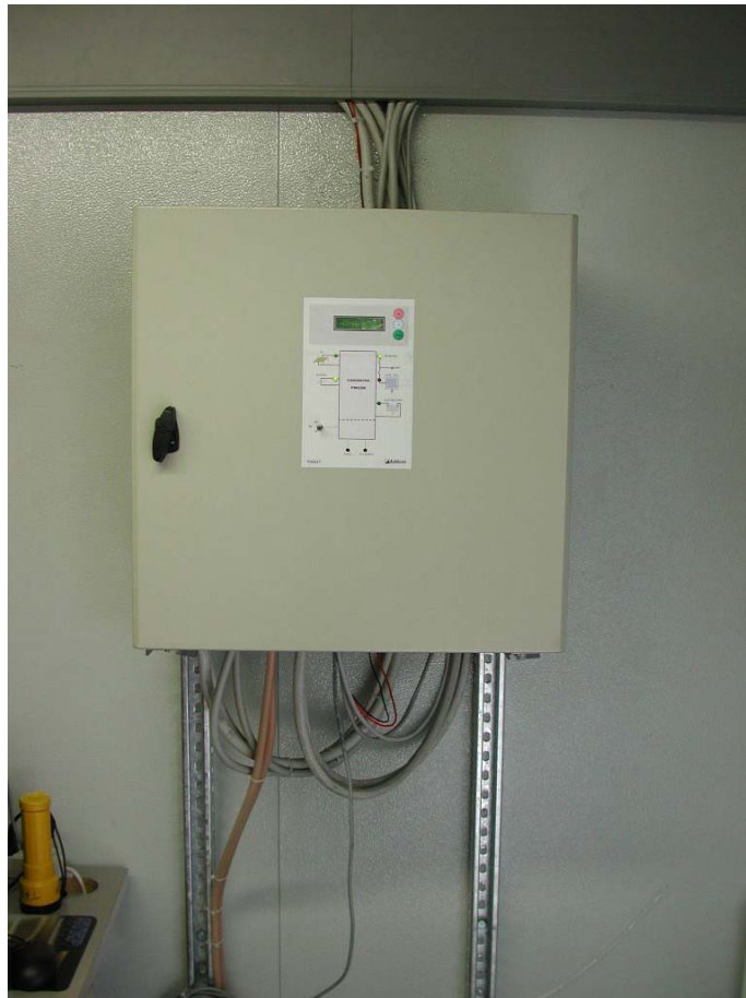
PMU : Appareil de conversion et de gestion du système (Ainelec).
