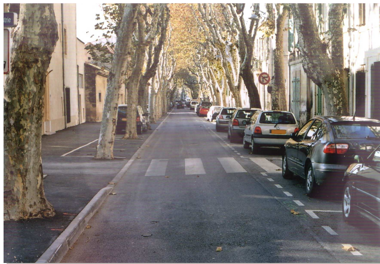
Figure 4 : Illustration de la faible perceptibilité en approche d'une intersection 37 combinée avec la présence de véhicules en stationnement masquant la visibilité (cliché de l'auteur).
