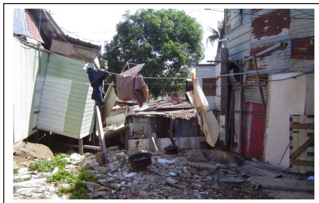
Photo 11 - extensions horizontales et verticales sur des cases de tôles à Eau Lisette (octobre 2004)
