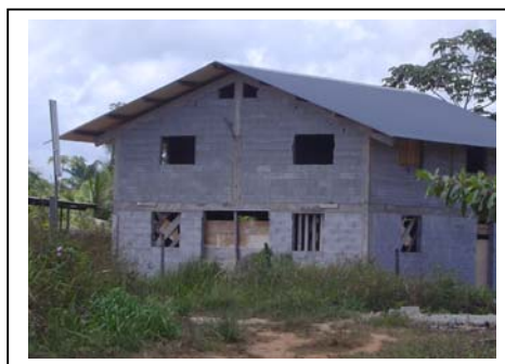
Photo 93 - grande maison en construction à Sablance (octobre 2004)
