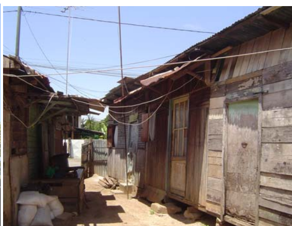
Photo 51 - Cases insalubres dans le jardin d'un propriétaire privé (Cité Eau Lisette, octobre 2004)
