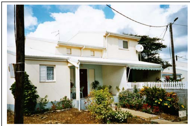
Photo 52 - Deux LAD à peine construits mais déjà appropriés, Cayenne (février 2004)
