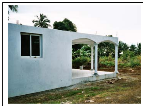
Photo 99 –Maison moderne en construction à Cayenne (février 2004)
