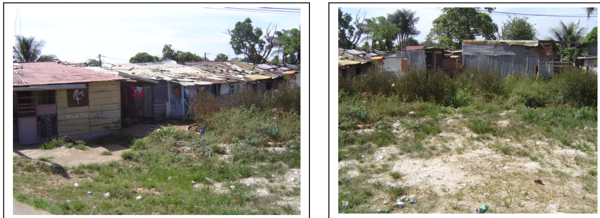
Photo 54 - Emprise libérée par les premières démolitions dans le bidonville d'Eau Lisette (octobre 2004)
