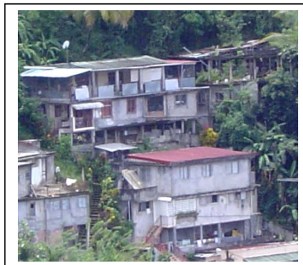
Photo 97 - immeubles dégradés à Trénelle (avril 2004)
