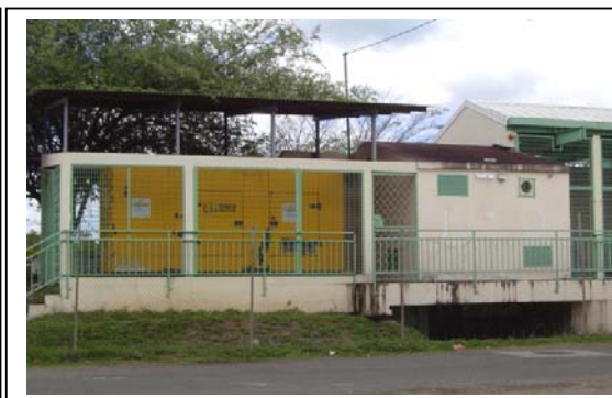
Photo 68 - Pompes à essence (avril 2004)
