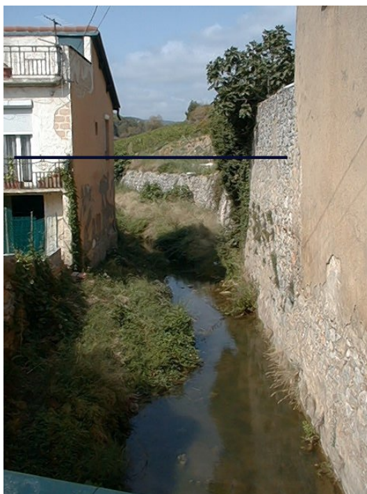
FIG. B.12 – Crue du Verdoble : maison du témoin 19 à Vingrau, vue de l'aval
