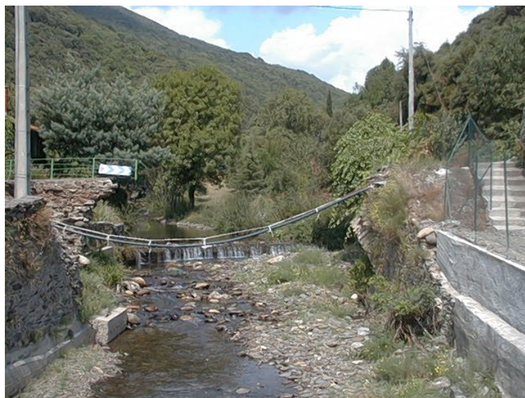
FIG. B.14 – Crue de la Clamoux : pont du hameau de Laval, vue vers l'amont.
