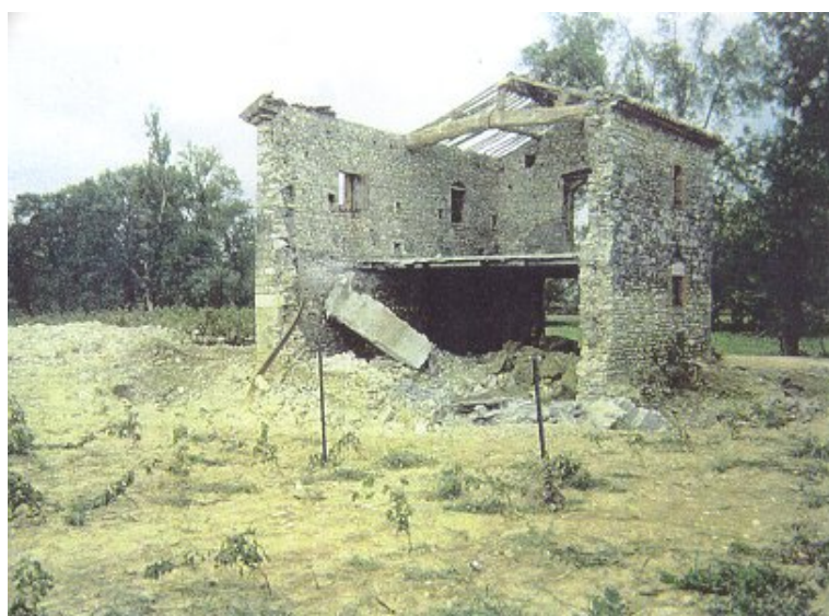
FIG. B.3 – Crue de l'Avène : ancienne grange détruite lors de la crue de l'Avène (commune de Saint-Hilaire de Brethmas).
