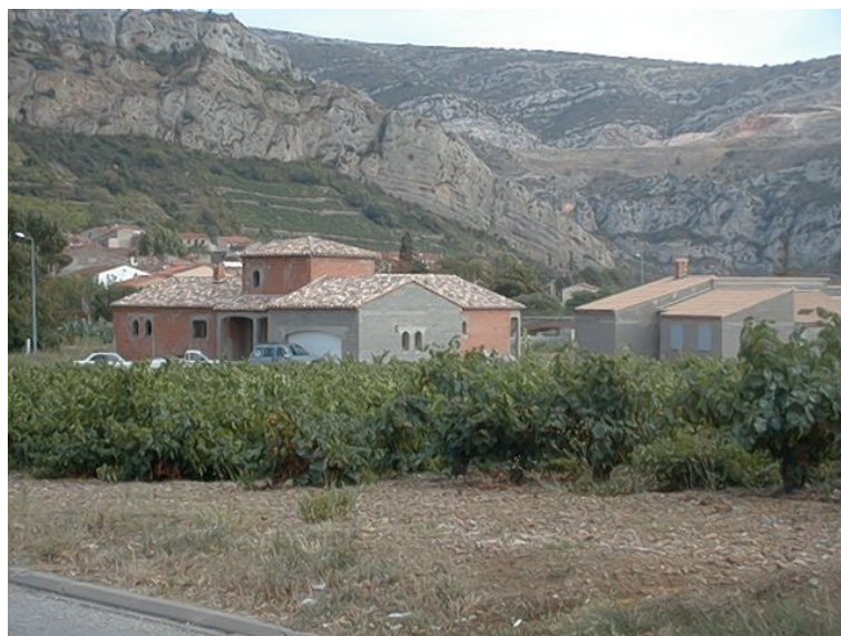
FIG. B.13 – Crue du Verdoble : maisons en constructions dans le lit majeur du Verdoble à Tautavel. Le pont quasiment submergé les 12 et 13 novembre 1999 est visible en arrière plan entre les deux maisons...
