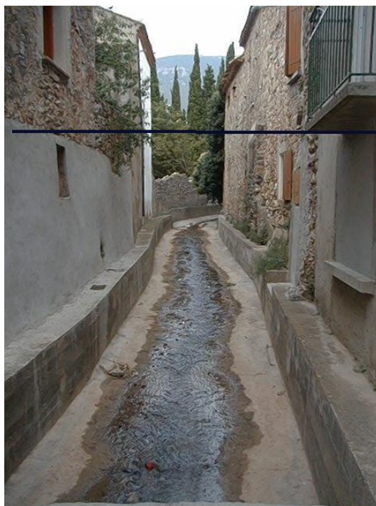
FIG. B.11 – Crue du Verdoble : vue vers l'amont du ruisseau des Nouyès à partir de la D.611 et niveau maximum atteint par les eaux les 12 et 13 novembre 1999. Certaines fenêtres ont été condamnées depuis la crue.
