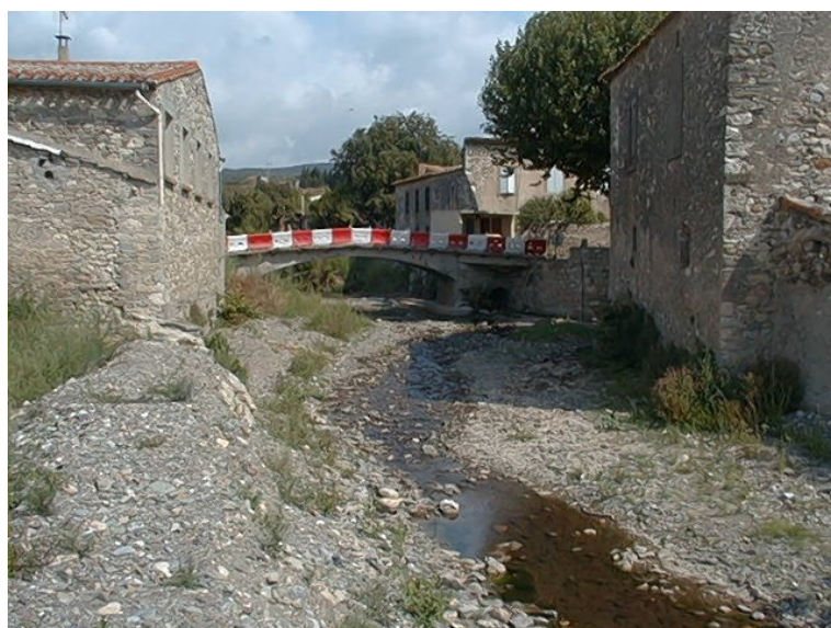
FIG. B.18 – Crue de la Clamoux : vieux pont de Villeneuve-en-Minervois vu depuis l'aval
