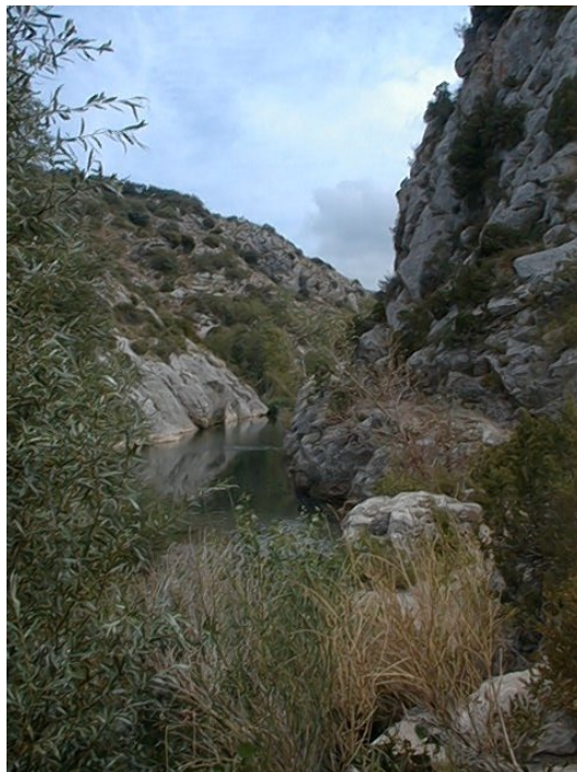
FIG. B.7 – Crue du Verdoble : entrée des gorges du Verdoble en aval de Paziols. Estimation de débit de crue 24.
