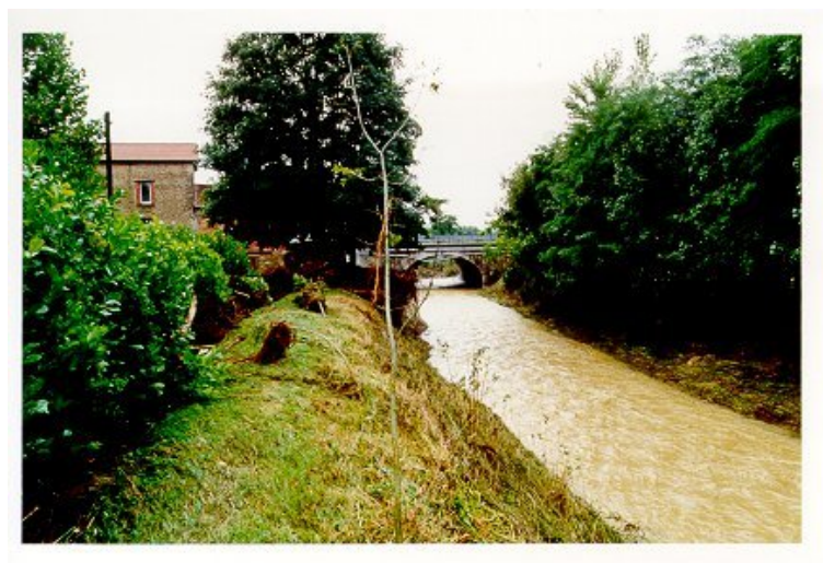
FIG. B.20 – Crue de la Drôme : pont du Cabaret Neuf vu de l'amont, le lendemain de la crue.
