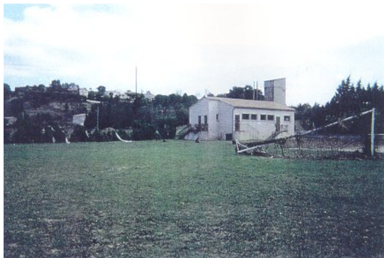
FIG. B.2 – Crue de l'Avène : laisses de crue le lendemain de l'événement dans le terrain de sport de la Jasse de Bernard situé en rive gauche à l'amont immédiat du pont.
