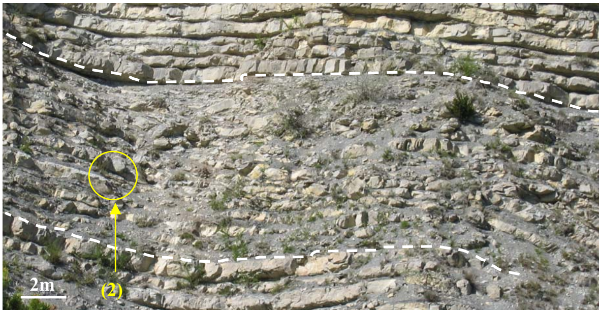
Figure 3.44 : Structures de déformation dans la partie 3.
