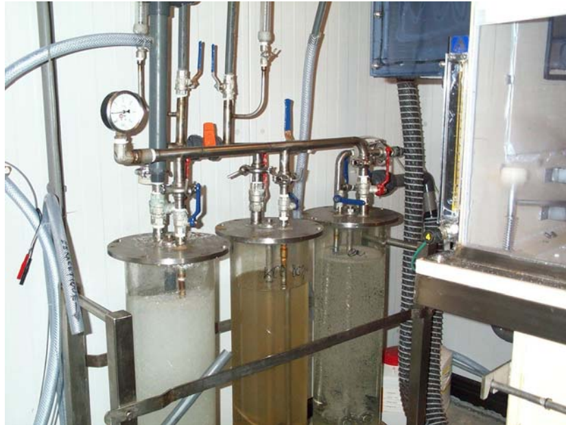
Figure II.4 : photographie du système de régulation de l'humidité relative de l'enceinte d'affinage.
