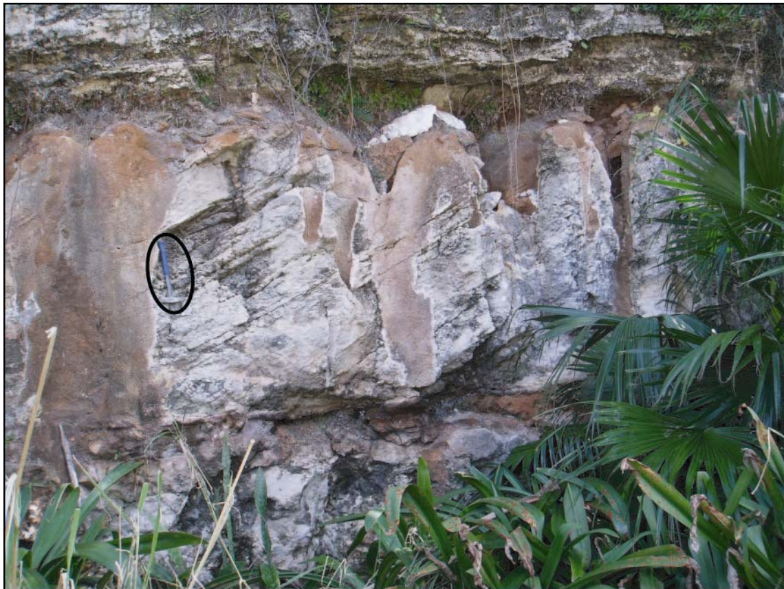
Figure 40 - Conduit karstique près de Castle Harbour Hotel (Site CH). Ici, la matière pédologique a disparu consécutivement à l'exposition du karst. La limite entre le karst et l'encaissant est nette.
