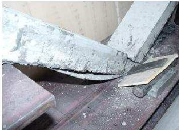
FIG. 9.18. Mode de ruine de la poutre 2 de (Limam et al., 2003a)
