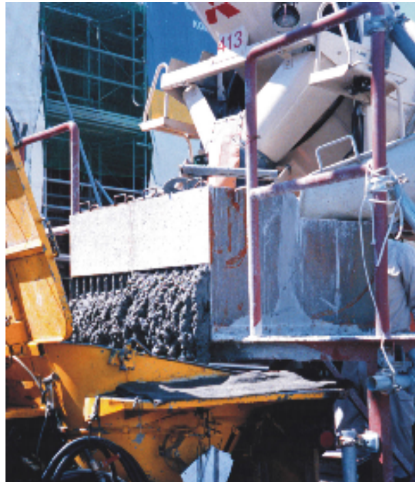
Figure 2.10: Contrôle de réception sur chantier au Japon [2]
