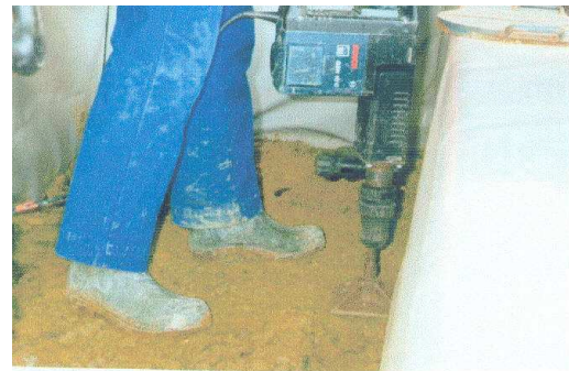
d) Compactage du matériau au marteau électrique
