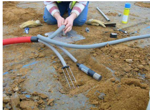
b) mise en place des différents capteurs
