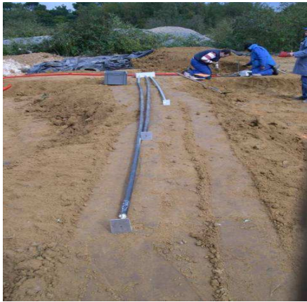
c) mise en place des capteurs pour les déplacements latéraux
