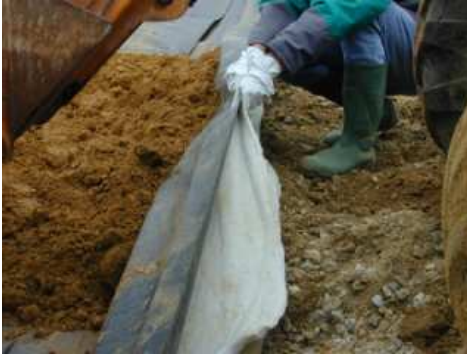
a) remontée du dispositif d'étanchéité
