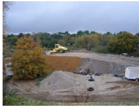
d) compactage des dernières couches
