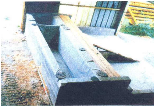
a) Enceinte pour recevoir les structures
