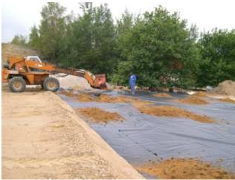
c) mise en place de la première couche
