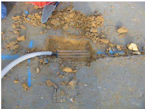
a) mise en place de la sonde TDR
