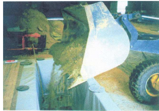
b) Mise en œuvre du matériau
