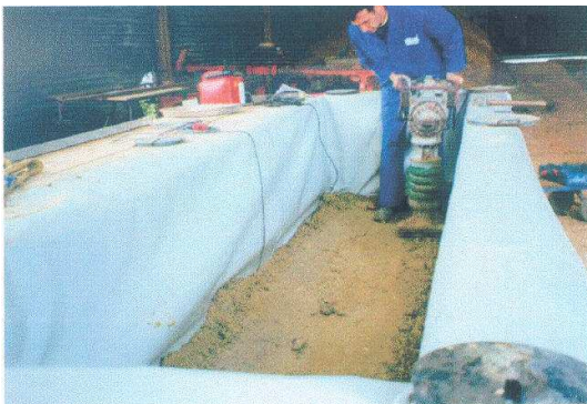
c) Compactage du matériau à la pilonneuse
