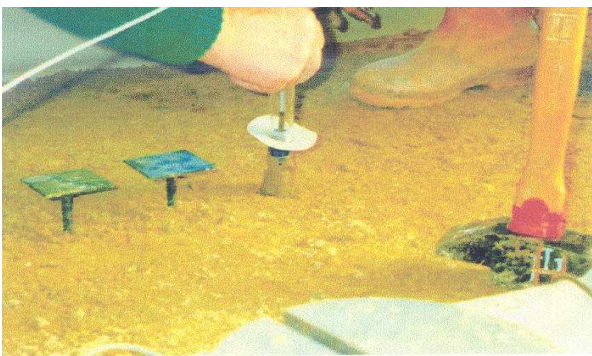
a) Mise en place des tassomètres
