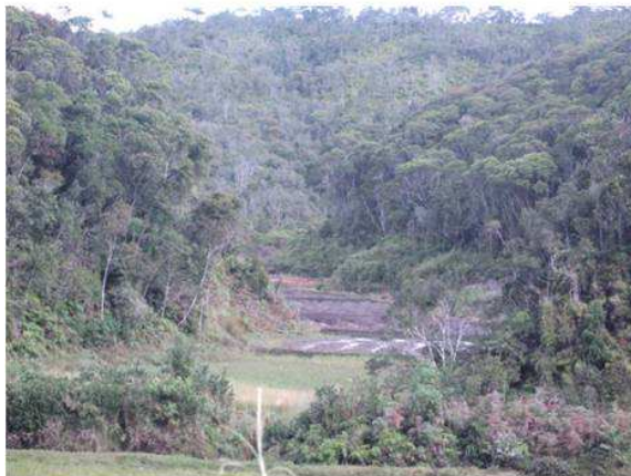
Aménagement en cours des bas-fonds le long de la voie ferrée
