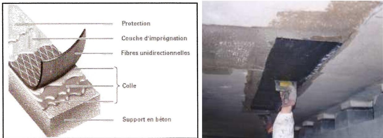
**Figure i.1** : Procédé de renforcement par collage de tissus en fibres de carbone
