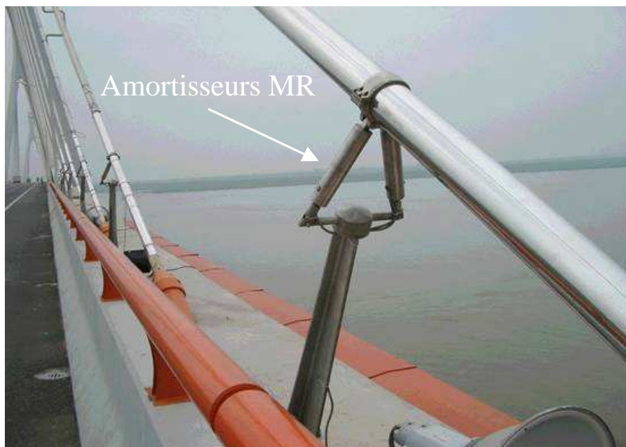
FIGURE 1.14 – Vue des amortisseurs MR intégrés au pont du lac du Dongting en Chine. D'après l'Université Polytechnique de Hong Kong.
