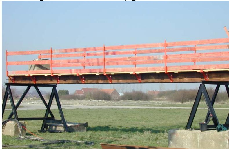
Figure 2.9. Guide de fonçage à structure bois
