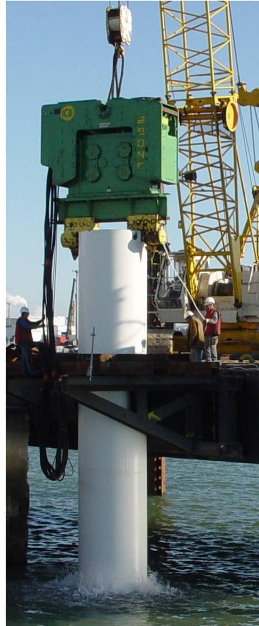
Figure 1.8. Vibrateur à fréquence standard ICE 250NF
