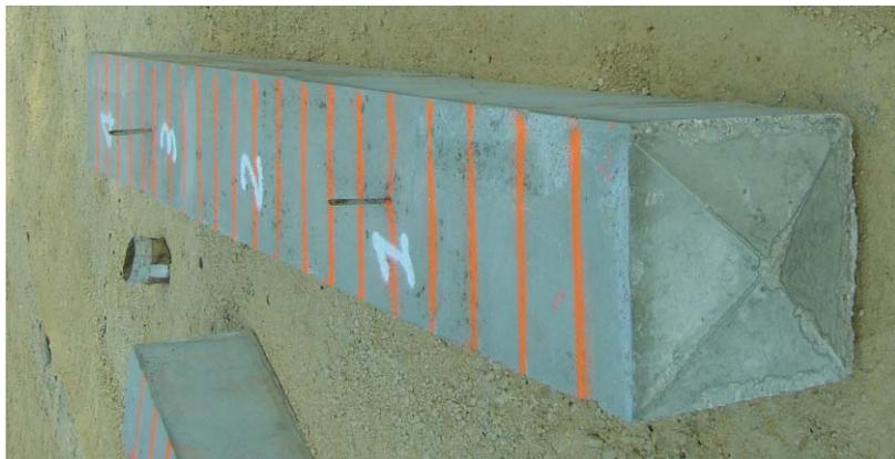
Figure 6.2.4. Les pieux en béton armé préfabriqués
