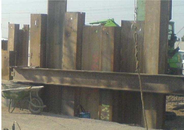
Figure 2.8. Guide de fonçage à structure acier
