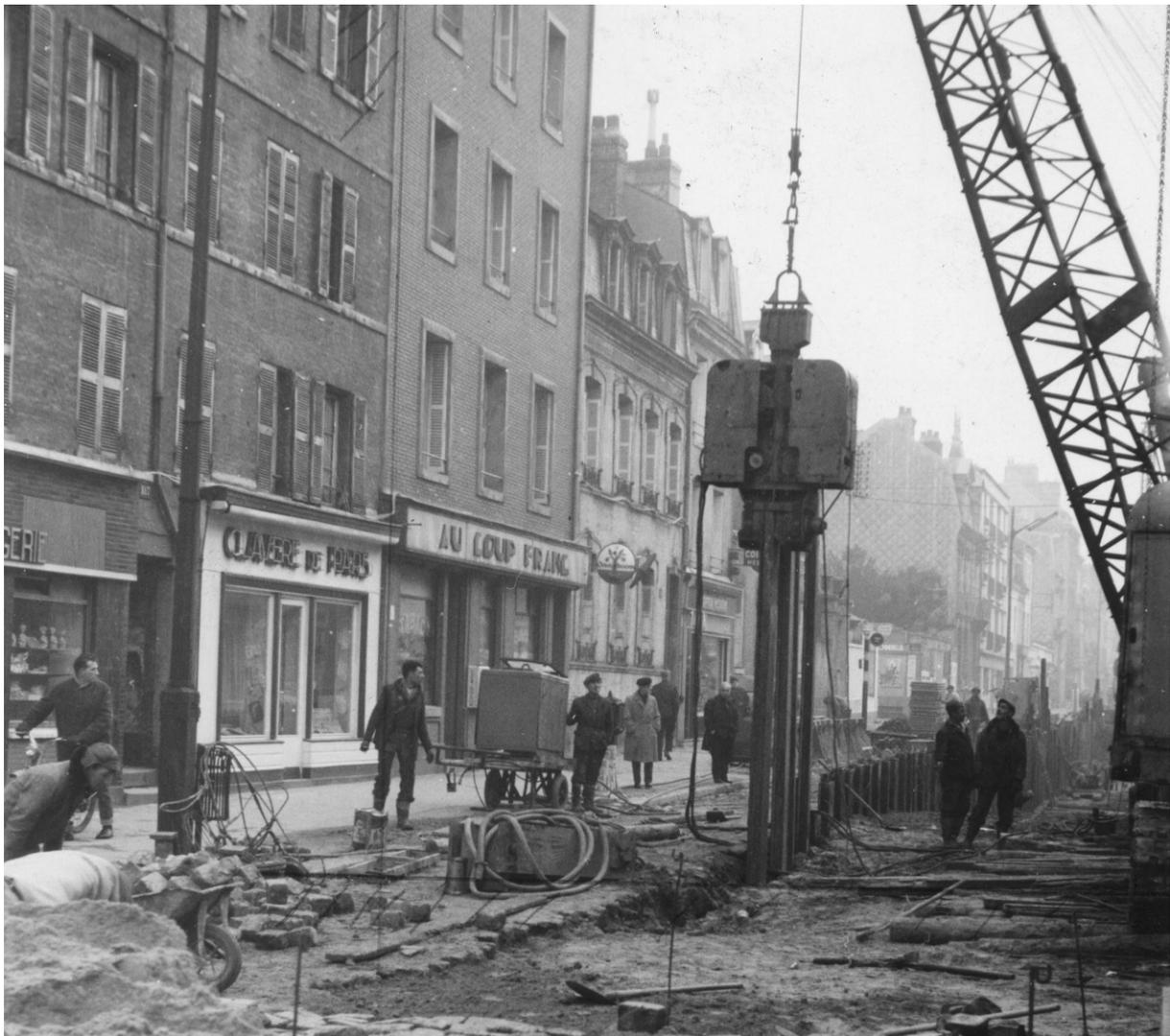
Figure 1.6. Vibrofonçage en ville dans les années 60 (Photographie de PTC)
