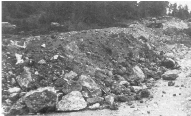
FIG. 1.5 – Execution d'un remblai routier sur la RN9.
