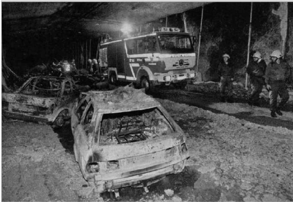
FIG. 1.1. Incendie du tunnel de Tauern en 1999
