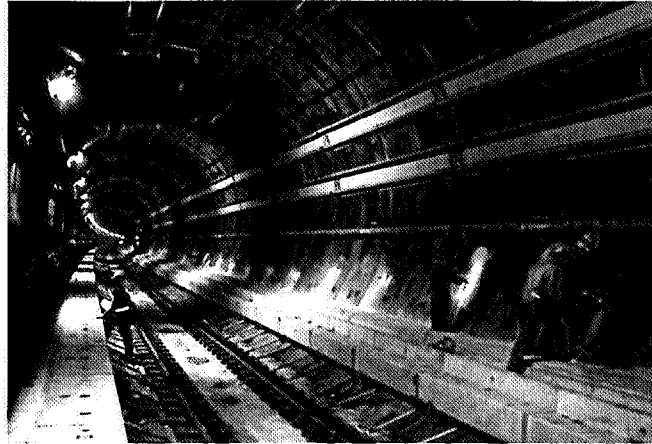
FIG. 1.1 – Auscultation d'un ouvrage souterrain.
