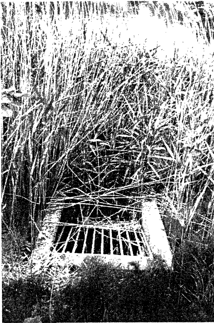
Photos 14 et 15 : Les ouvrages de débit de fuite de sécurité
