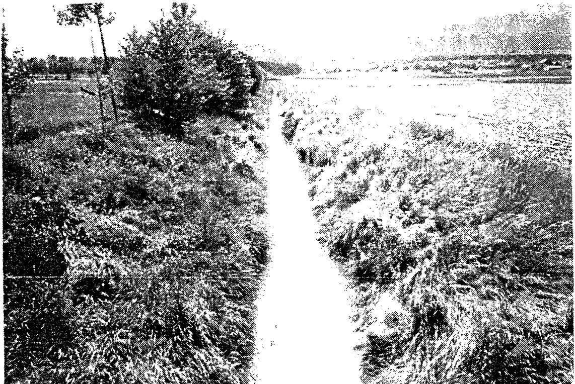
Photo 2 : Canalisation (à ciel ouvert) de la rivière LA THIELLE - Exutoire Lac de Neuchâtel.
