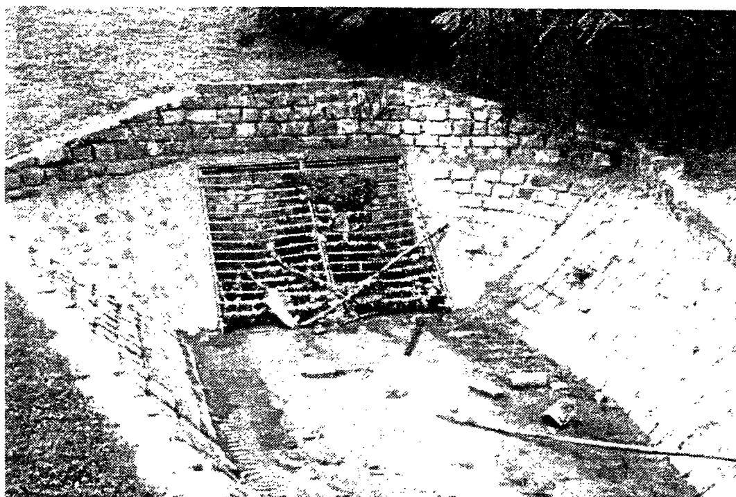
Photo 12 : Avaloir d'aval du bassin de rétention des MOUSSEAUX
