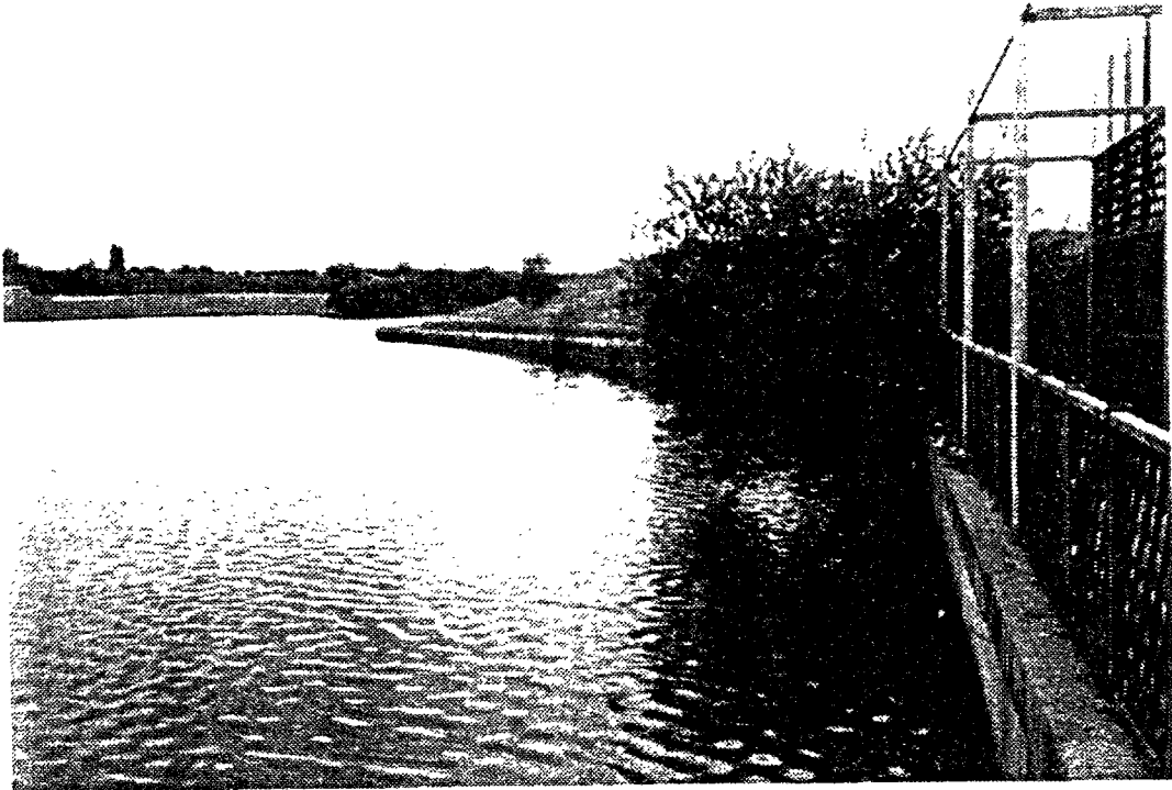
Photo 19- Le bassin de SAVIGNY et l'ouvrage de surverse en premier plan.
