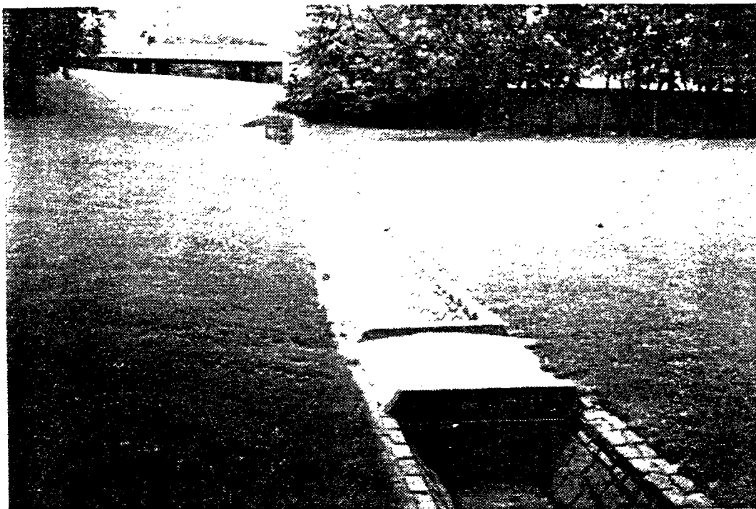
Figure 11 : Vue d'ensemble d'un bassin de rétention des MOUSSEAUX, planté
