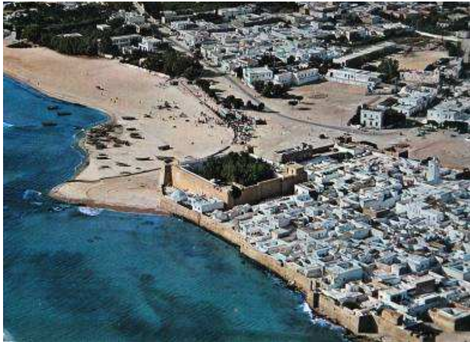
Figure 34 : Les terrasses planes et chaulées des maisons de la médina de Hammamet
