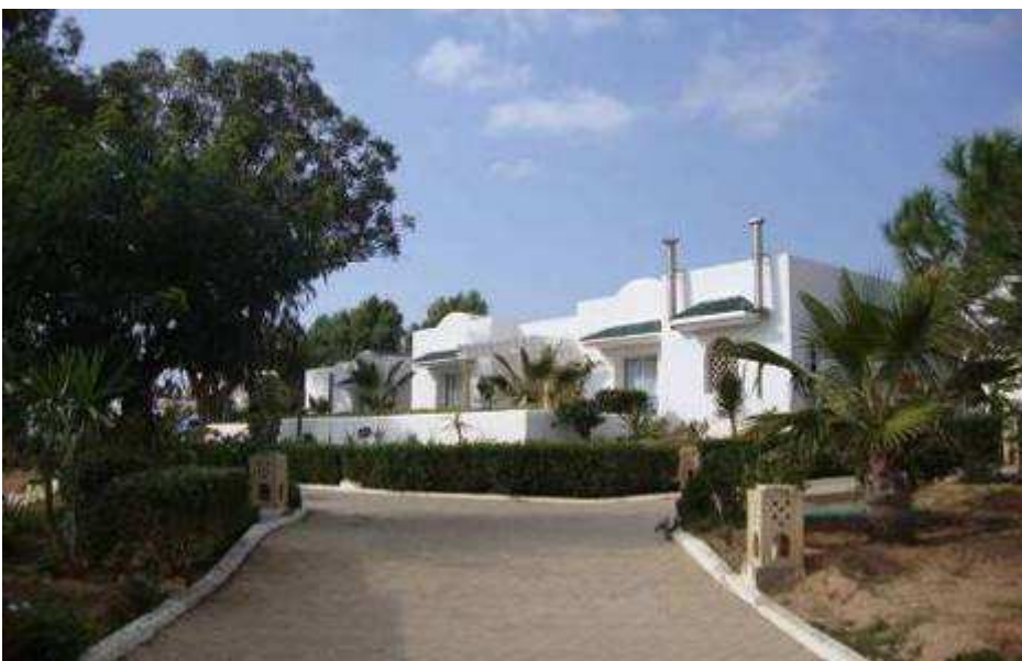
Figure 108 : Dénivellation entre les allées et les parcelles à l'hôtel Villas de Hammamet.
