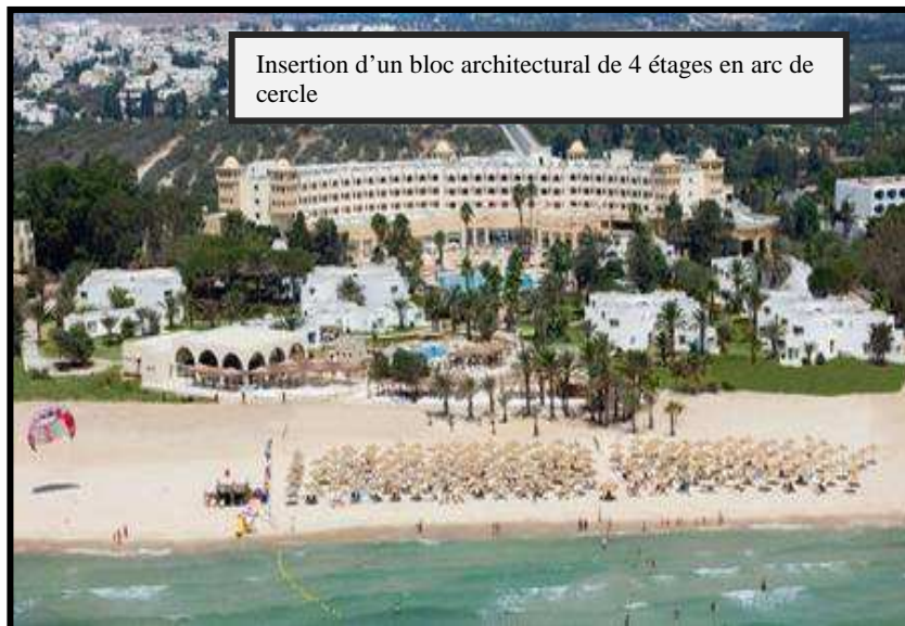
Figure 115 : implantation d'un bâtiment de quatre étages à l'hôtel Sheraton (1971) devenu Riu Palace en 2009
