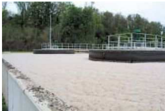
Figure 3 : Mousse biologique en surface de bassin d'aération (d'après Document technique FNDAE N° 33)
