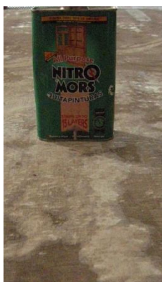
Figure 23 : le Nitromors® et auréoles de plomb provoquées par le décapage au gel
