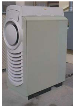
Figure I-10. Capstone Model 330, connecté au réseau, gaz naturel à basse pression
