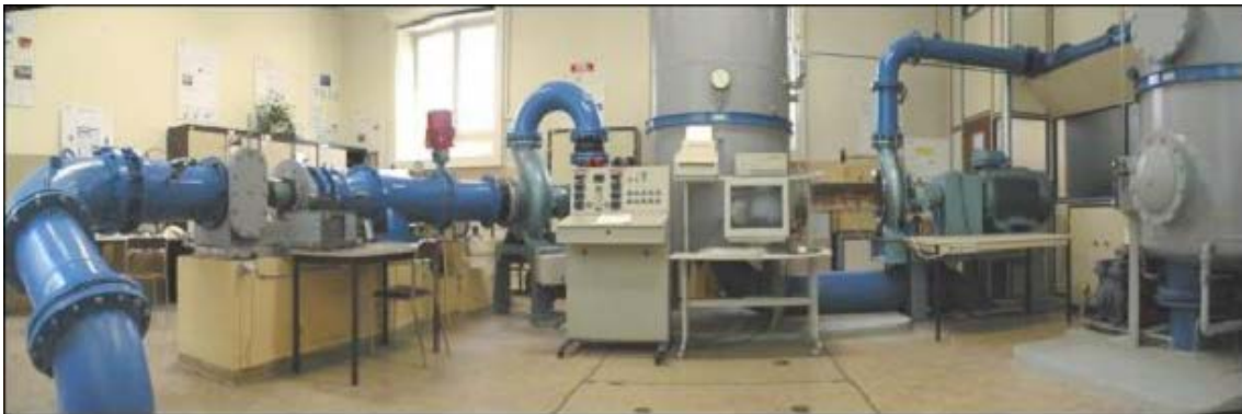
FIGURE 2.1 : Banc d'essais des pompes centrifuges et axiales du DynFluid.
