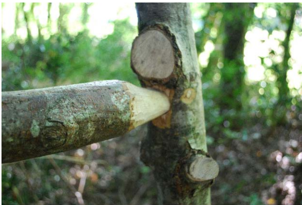
# 35 : Détail de l'assemblage des branches par emboîtement dans le projet 'Echelle'
