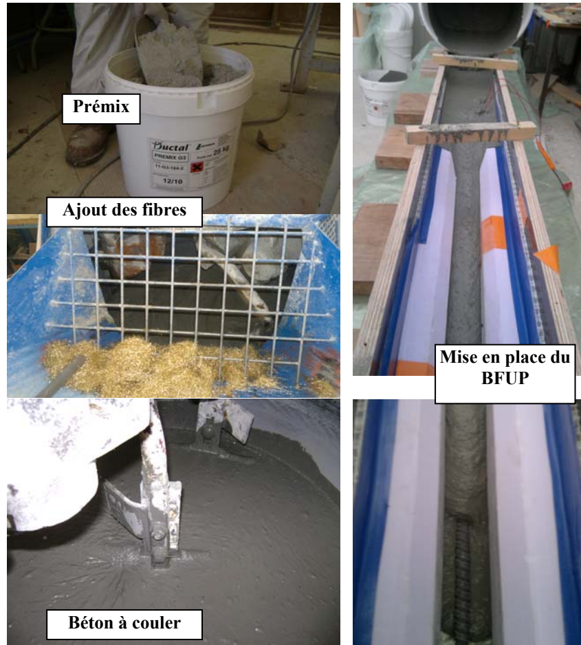
Fig.3.20 Coulage du BFUP
