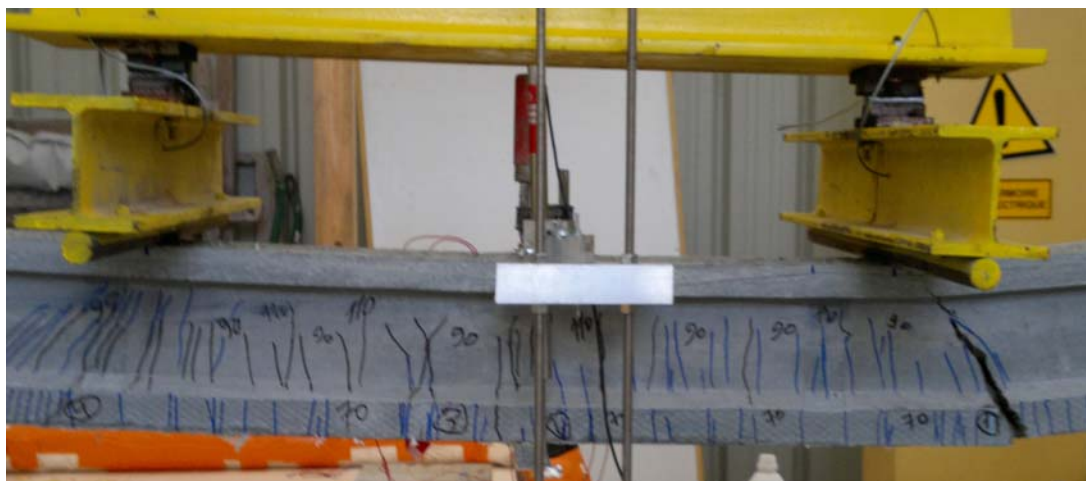
Fig.4.17 Rupture de la poutre PP-JC12 par effort tranchant
