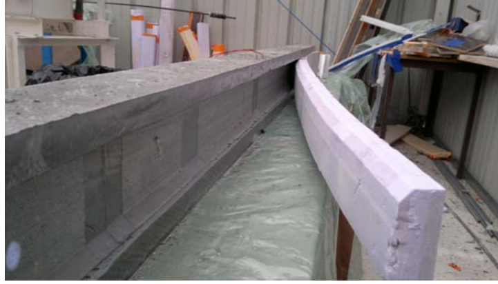
Fig.3.21 Démoulage des poutres
