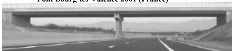
Fig.1.51 Exemples représentatifs des ouvrages réalisés en BFUP en France
