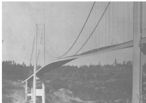
FIG. 1 – Oscillation du pont de Tacoma précédant son effondrement.
