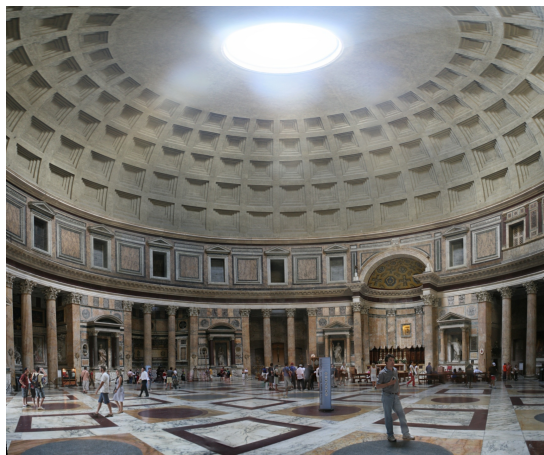
FIGURE 1 – La voûte intérieure du Panthéon de Rome.
