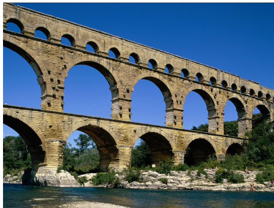
FIGURE 2 – Le pont du Gard, utilisé comme aqueduc avant le VI^e siècle.
