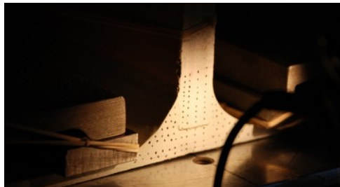
Figure 4.7 Soulèvement des brides : le composite ne touche plus le bâti au droit des cales de bridage
