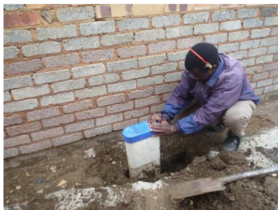
Illustration 22 – Etape 2 : déterrer le compteur
