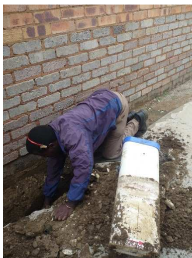
Illustration 23 – Etape 2 : déterrer le compteur
