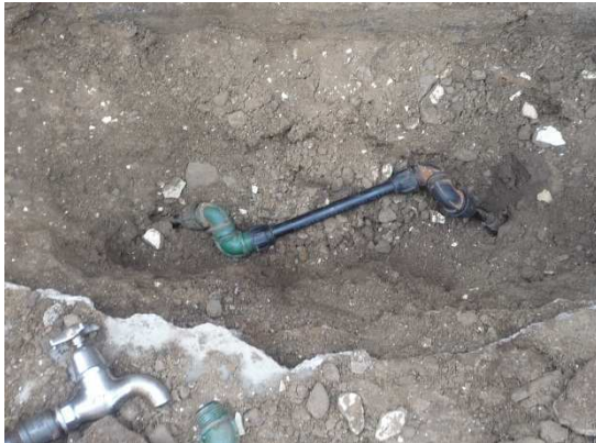
Illustration 26 – Etape 5 : Mise en place du conduit de raccordement artisanal
