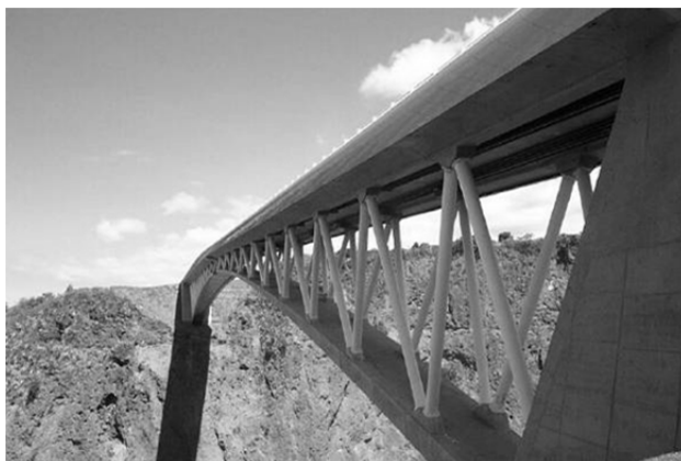
Figure 1 : Pont sur le Bras de la Plaine
