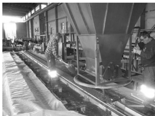
Figure 8 : Coulage d'un élément d'essai
