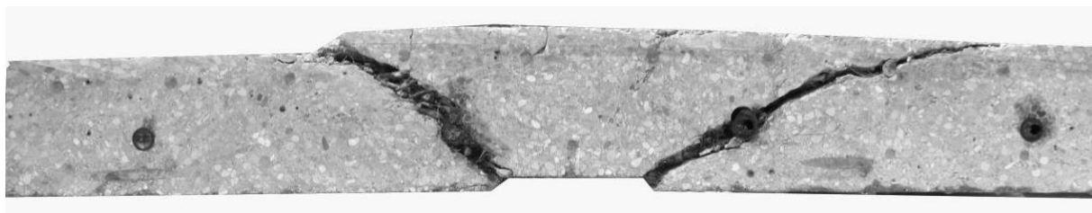
Fig. 95 : Fissuration à plusieurs niveaux de charge et fissures internes de la dalle B5-02.
