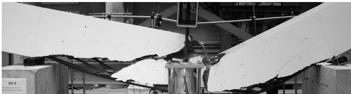
Figure 32 : Aspect à la rupture de l'élément AV-2
