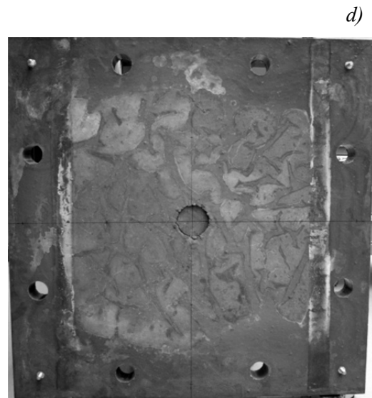
d) Fissuration de la face comprimée
