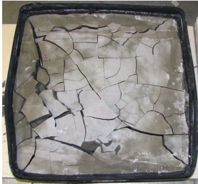
Figure 2.71 Fracturation dans la masse après 10 cycles de gel-dégel dans les conditions de l'essai d'écaillage, d'un coulis E/C=0,45 avec adjuvant entraîneur d'air (0,2% du ciment en masse)
