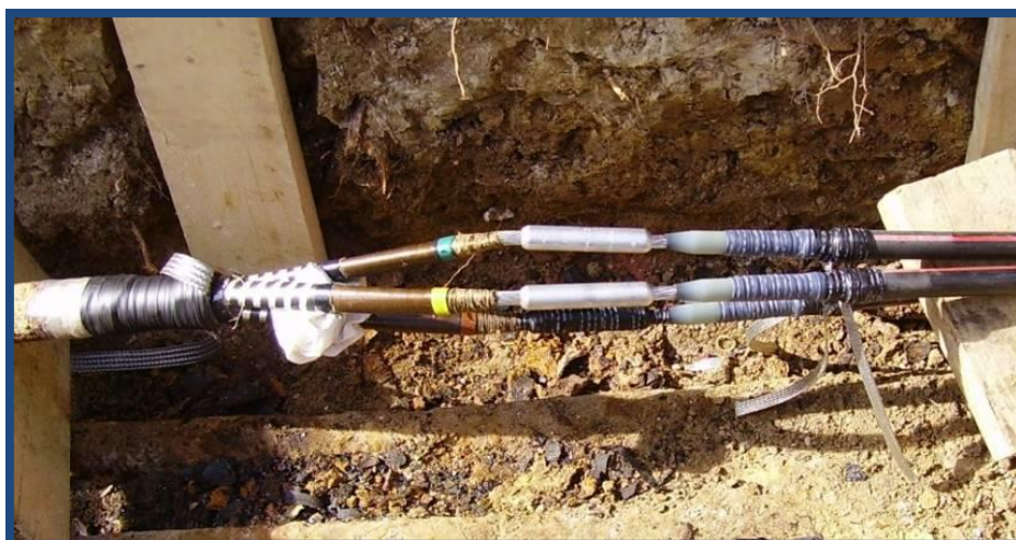
Figure 3. Photographie d'une transition en cours de fabrication.
