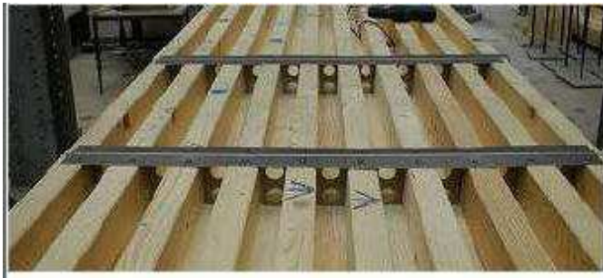
Figure 1-6 : Dalle mixte bois-béton développée par le groupe CBS-CBT (D-Dalle). Portée de la poutre :11 m à 18 m ( http://www.cbs-cbt.com ).
