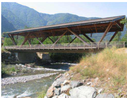
Figure 1-4 : Pont "des Fayettees" dont la mixité du tablier est assurée par le système de connexion Bertsche (Flach M., 2000).
