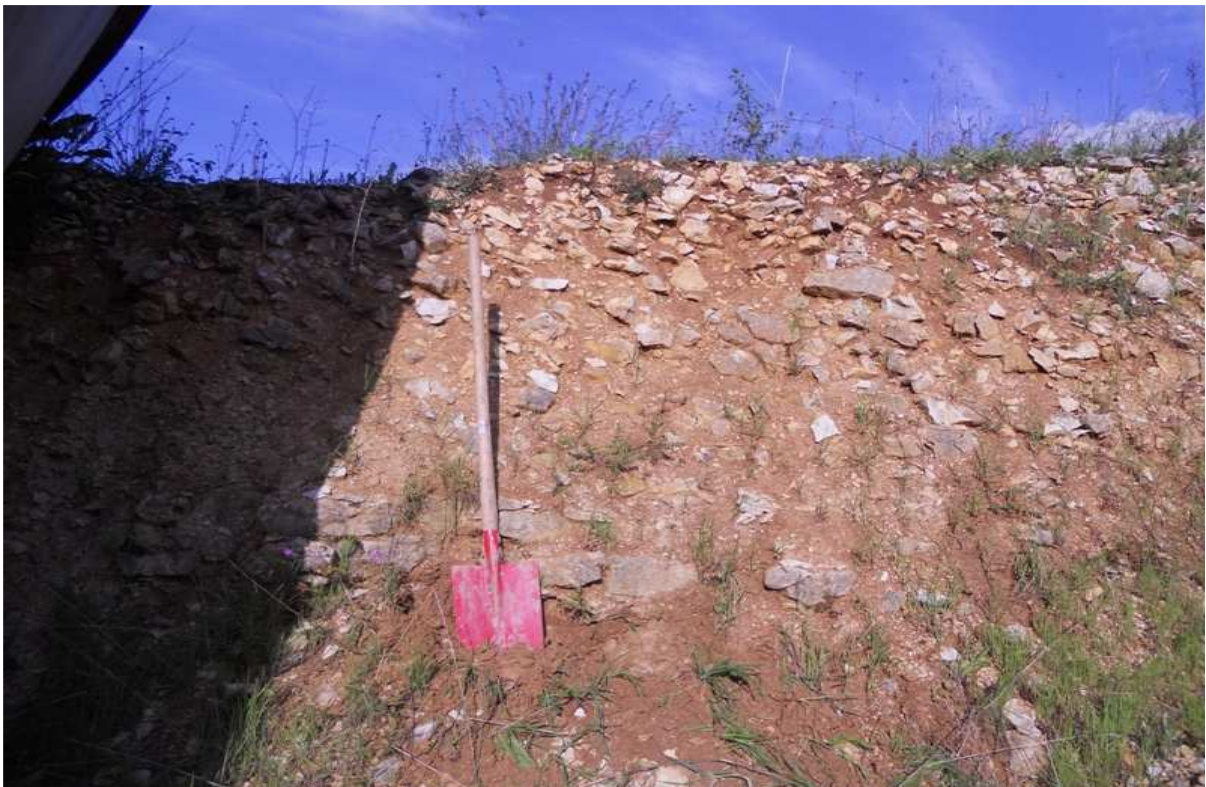
Figure 19. Profil du talus du versant en face du site pilote, avec des bancs de calcaire stratifiés en bas du talus à gauche et au milieu. La couleur de la matrice fine est différente.
