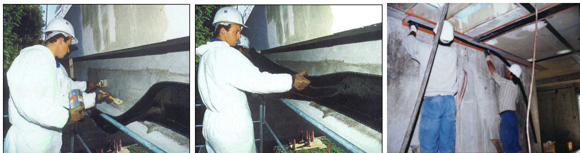
FIGURE 1.1 – Réparation par collage de plats PRF (Photos Freyssinet International)
