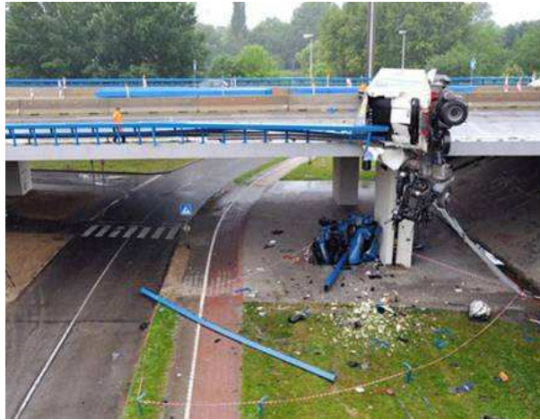
FIGURE 5.1 – Anciennes glissières de sécurité
