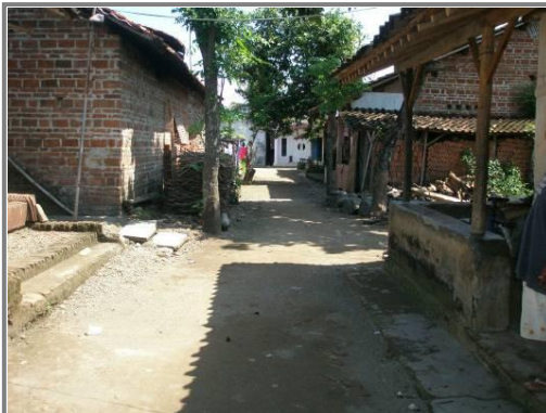
La plupart des quartiers pauvres se développent spontanément sans infrastructures, (photo à Kalisasak, un village reclassifié).
