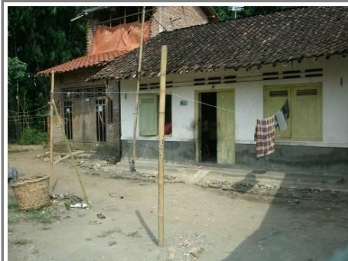
Beaucoup des maisons des ménages urbains pauvres dans les zones urbaines sont auto-construites par les ménages (à Talang).
