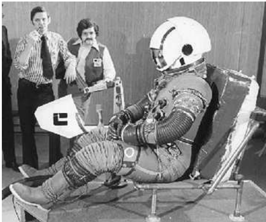
Fig. II-1 : Combinaison spatiale munie d'articulations à soufflets.
