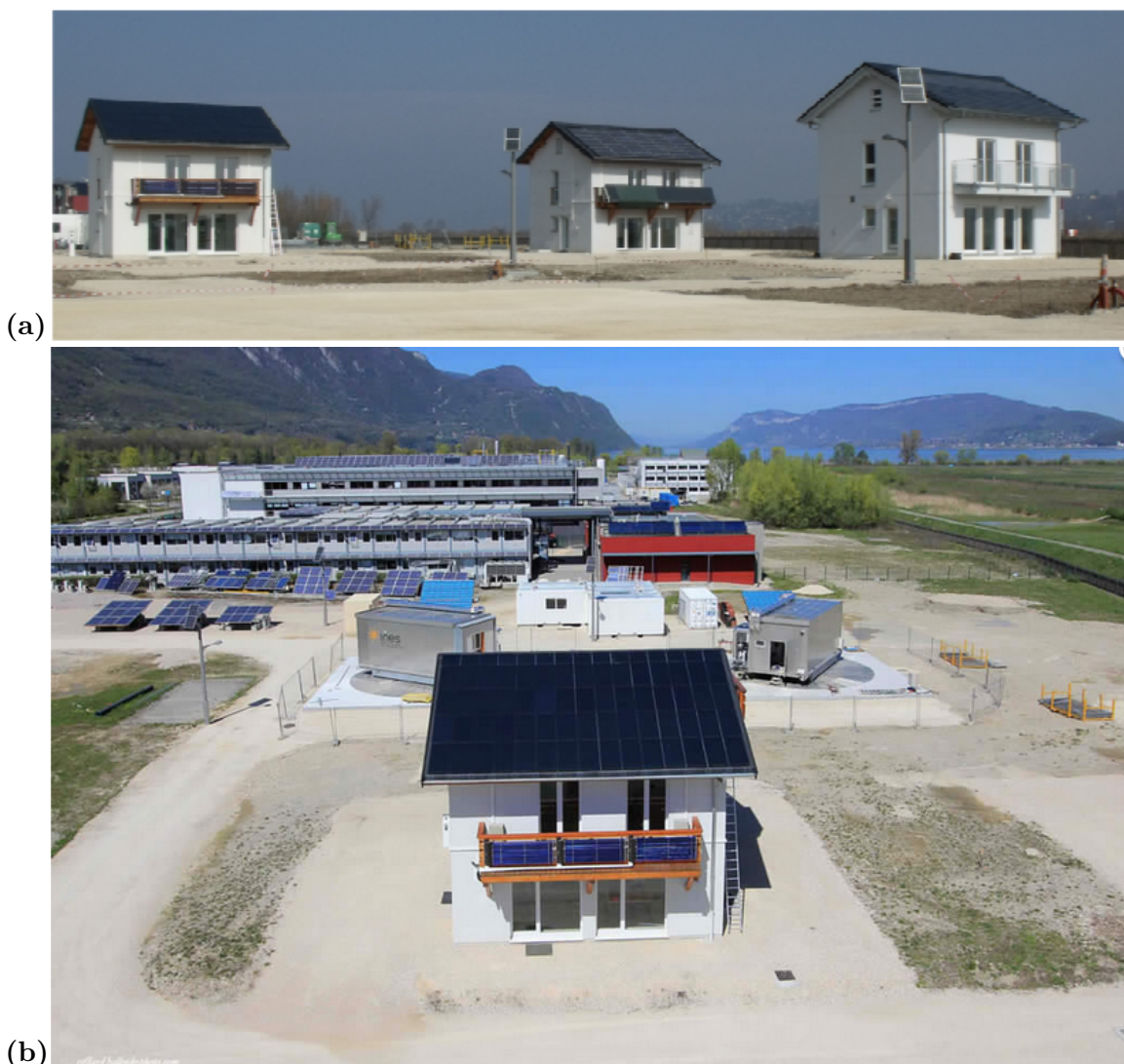
FIGURE 4.1 – (a) Vue de la plateforme INCAS de l'INES : I-BB (à gauche), I-DM (au milieu) et I-OB (à droite) ; (b) Vue aérienne de la maison I-BB (au premier plan), des cellules PASSIS et de l'INES (au second plan) – Crédit photo P.Riffard (CEA)
