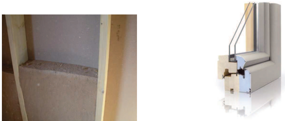
Figure 141. Isolation des murs entre montants, double vitrage peu émissif avec lame d'argon
