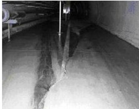
FIG. 1.1 – *Soulèvement puis dislocation du radier d'un tunnel* <sup>[100]</sup>
