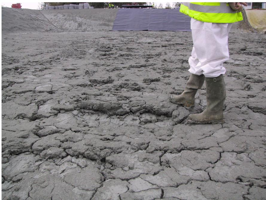
*Figure I-10 : Exemple de surface de barrière minérale compactée de façon inappropriée*
