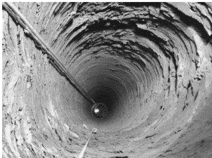
Figure 0-4a : Dégradation autour du puits après la fermeture (Derek Martin et al. 2003).
