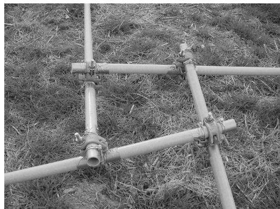
FIG. 3.28 – Assemblage MERO™ typique.      FIG. 3.29 – Assemblage typique d'une nexorade.
