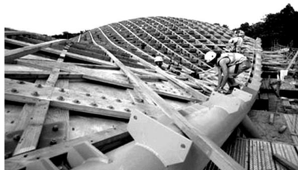
FIG. 1.23 – Ancrages de la couverture.
