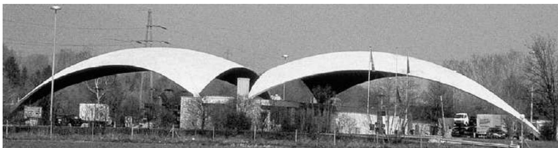
FIG. 1.7 – Coques de Heinz Isler au-dessus d'une station service.
