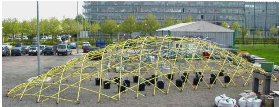
FIG. 5.1 – Vue extérieure du prototype de gridshell en composites.
