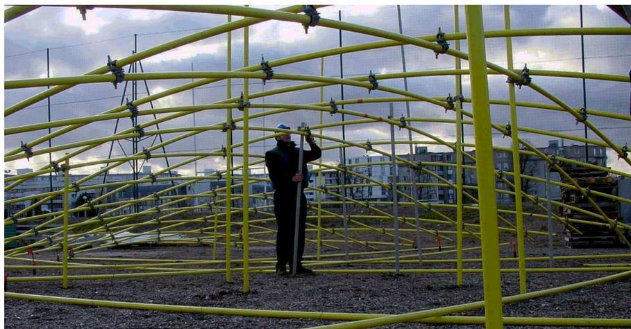
FIG. 6.2 – Mise en forme du prototype au moyen d'étais et de tirants.
