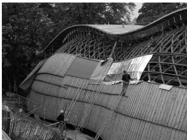
FIG. 1.17 – Couverture du gridshell de Downland en court de montage.
