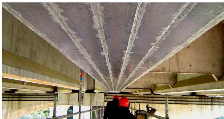
FIG. 2.2 – Chantier de renforcement d'un pont sur l'autoroute A6 près de Toutry.
