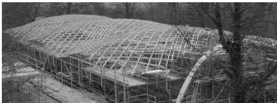
FIG. 1.20 – La structure du gridshell de Downland en cours de montage.
