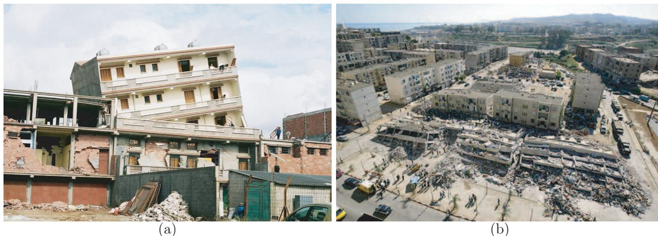
FIG. 3.2 – Photographies à Boumerdès, après le séisme. – (a) Bâtiment qui s'est affaissé sur un côté seulement; ce type de dégâts est difficile à détecter avec certitude sur des images satellite avec les résolutions actuelles. – (b) Effondrement total de bâtiments suite aux secousses.
