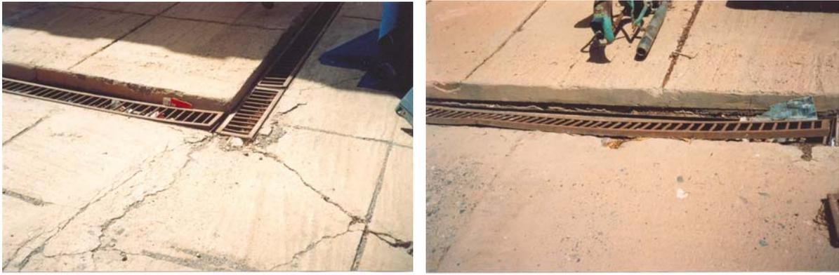
Figure 18. Rupture d'un collecteur d'eaux superficielles (ONEP, Ouarzazate)
